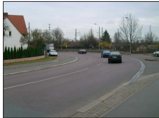
Abbildung 30: Raffineriestraße (Blickrichtung Südost)
