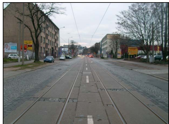
Abbildung 57: Delitzscher Straße (Blickrichtung West)
