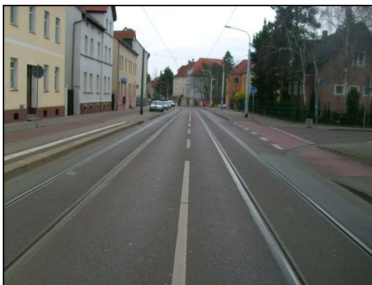
Abbildung 50: Kröllwitzer Straße (Blickrichtung Südost)
