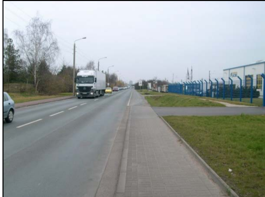
Abbildung 31: Leipziger Chaussee - Abschnitt Nord (Blickrichtung Nordwest)
